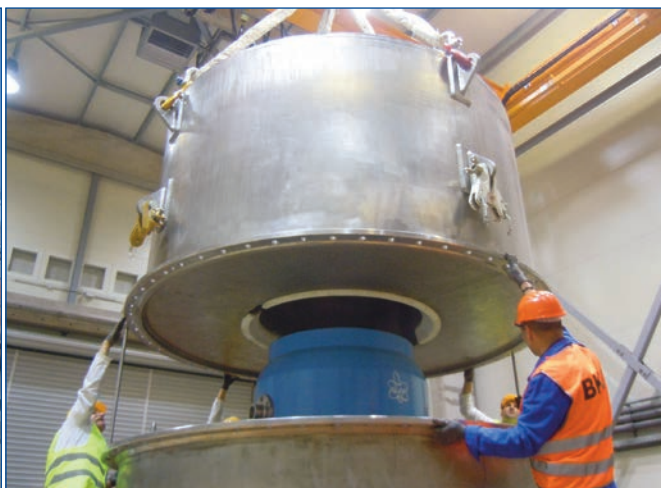
Colocación del contenedor externo de absorción de choque sobre un contenedor de transporte cargado con combustible gastado de HEU, para su transporte aéreo.
