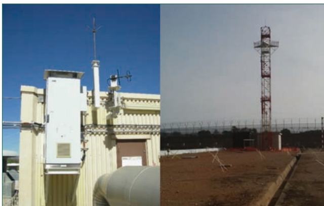
Figura 6. Estación base y torre instalada.
