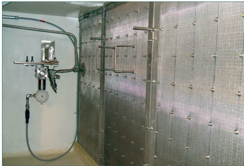
Figura 3. Instrumentación de medida del diferencial de presión y puerta de acceso a cámara interior.
