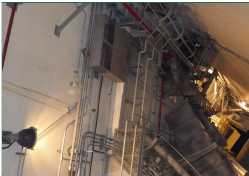
Figura 6. PAR en hueco equipos Contención.
