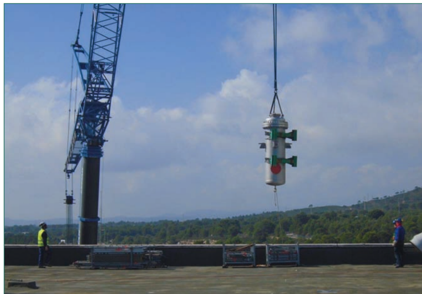
Entrada de equipos.
