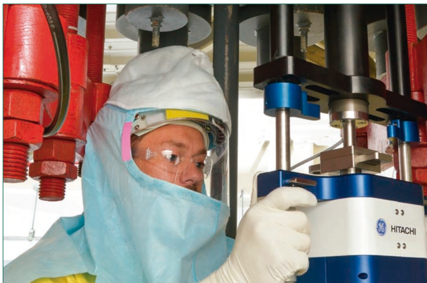
Instalación de la Herramienta de Desacoplamiento en Remoto.
