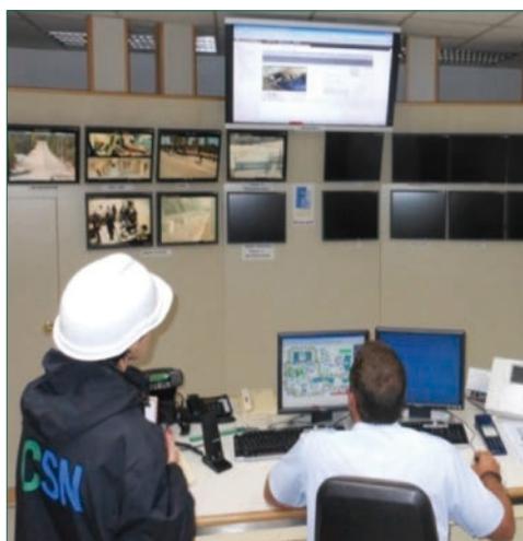
Foto 3. Inspección del CSN a la central de control de alarmas.
