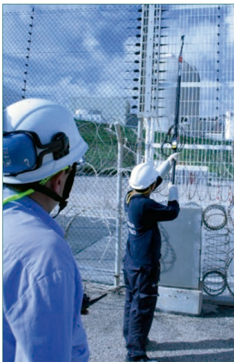
Foto 2. Inspección de los sistemas de seguridad física del doble vallado.
