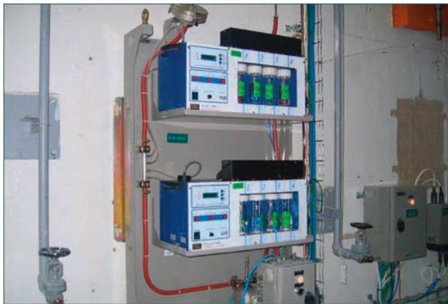
Muestreador H-3 y C-14 en aire C.A. Cabril.
