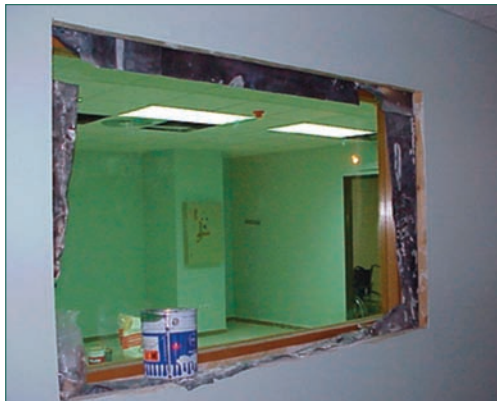
Figura 5. Blindaje estructural en paredes.
