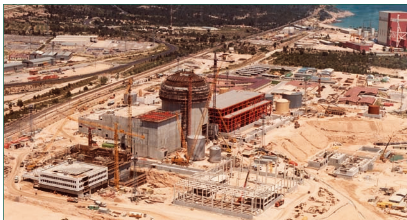
Construcción de la central nuclear de Vandellós II. Al fondo, Vandellós I.
