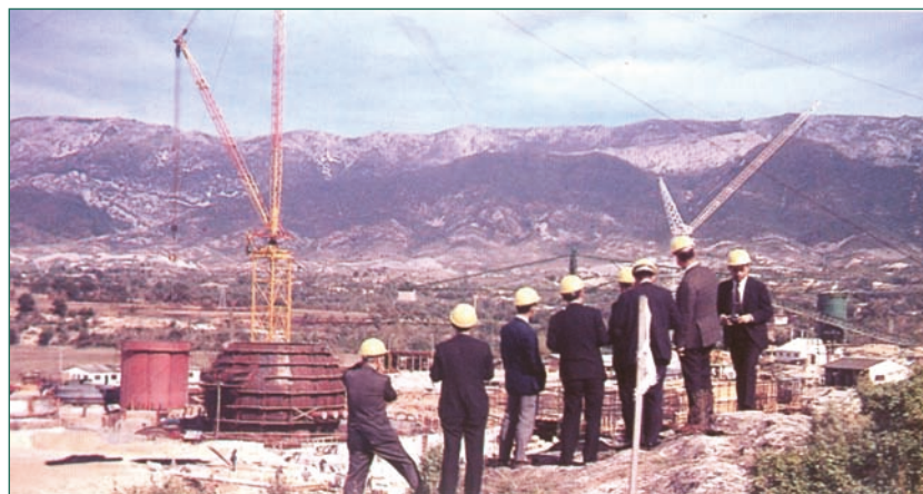
Construcción de la central nuclear de Santa María de Garoña.
