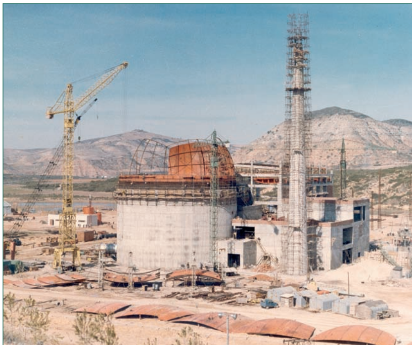
Construcción de la central nuclear de José Cabrera (Zorita).
