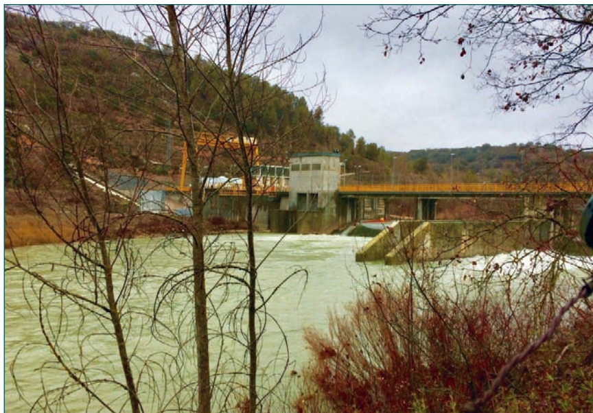
Figura 1. Vista de la captación y descarga de agua de la Central de Trillo, incluyendo la escala de peces.
