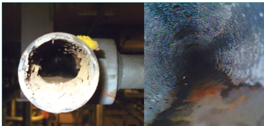
Figura 5. Detalle del estado anterior (izquierda) y posterior (derecha) a la limpieza de línea de Contra Incendios.
