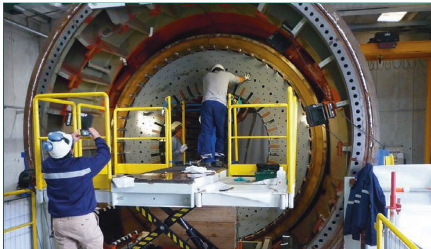
Instalación de chapas nuevas.
