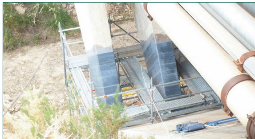
Refuerzo en la base del puente del barranco Lleira.
