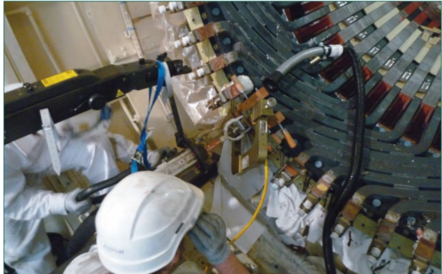
Brazing de cabeza de bobinas.
