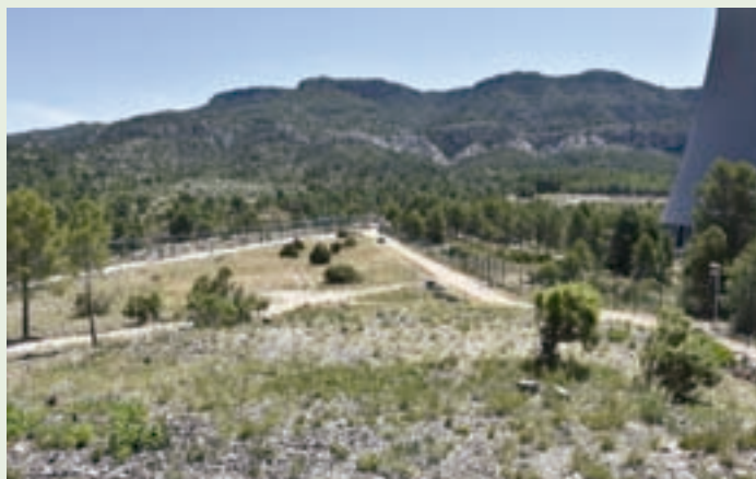
Zona destinada a la construcción del ATI.
