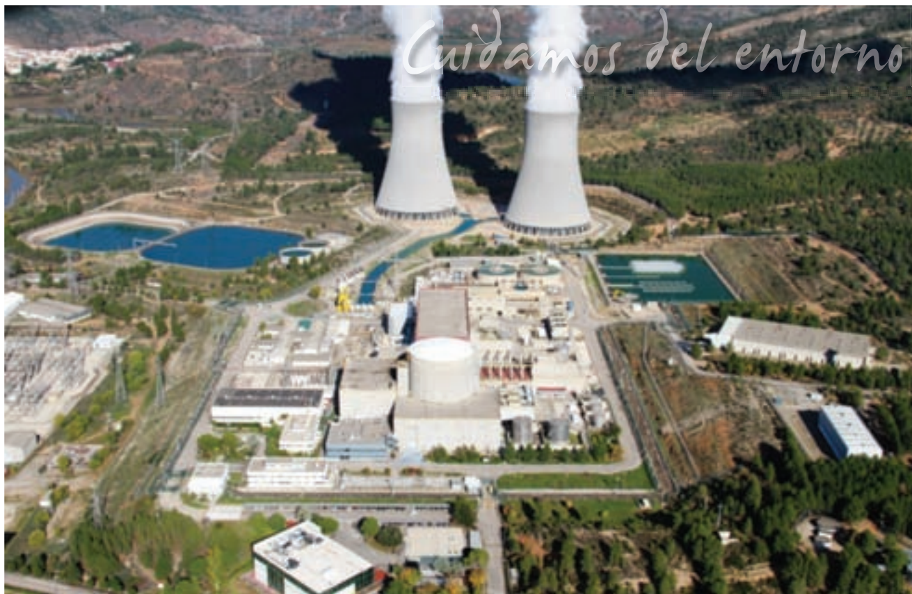
Disposición actual de edificios de C.N. Cofrentes.
